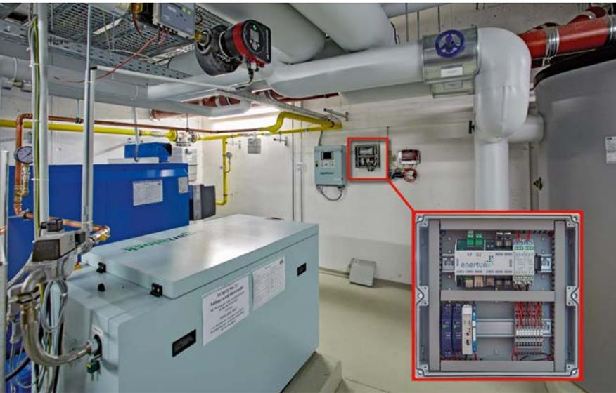
Der enertune manager wird im eigenen Schaltkasten fertig zum Einbau geliefert. Die Sensoren lassen sich bei laufendem Betrieb installieren.
